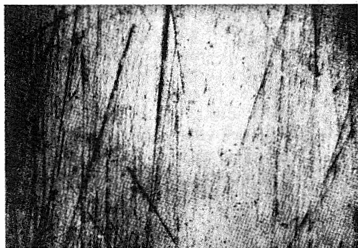
Fig 1. Välputsad plastfasadyta i akrylat.
